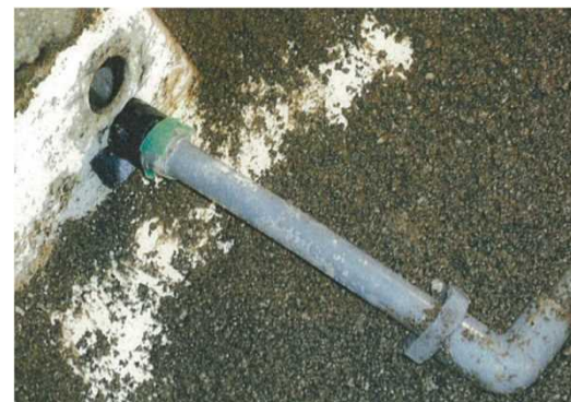
故障した配管（改築前）
